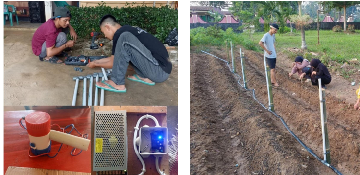
Gambar 3. Perakitan dan Pemasangan Alat
